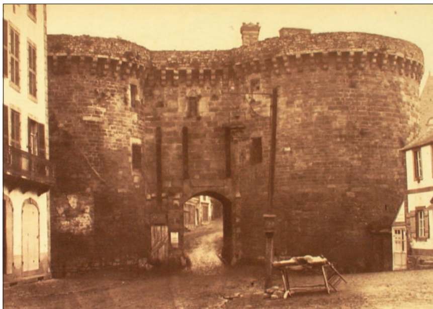
Fig. 65 : La porte de Brest avant démolition [MdB R, 939.0028.317].
